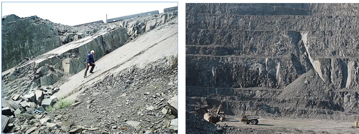
Рис. 1. Плоский (слева) и клиновидный (справа) вывалы блоков пород по трещинам на уступах карьеров
